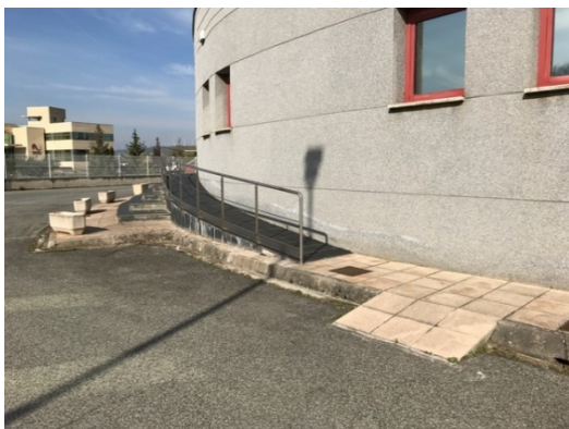
PARKING Y RAMPA DE ENTRADA
