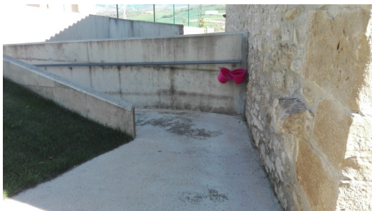
RAMPA DE ACCESO AL MUSEO
