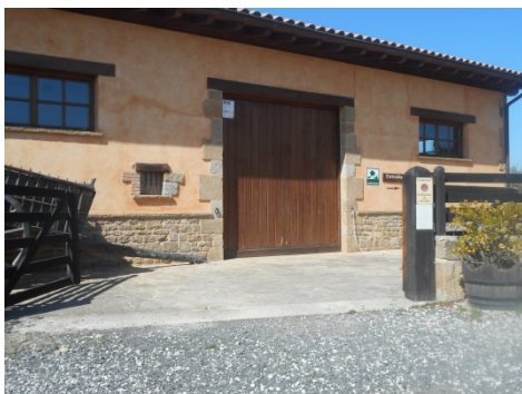
ENTRADA AL EDIFICIO
