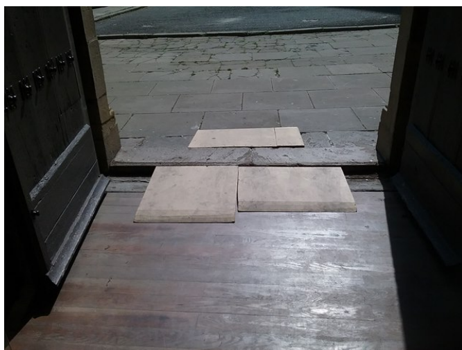
Acceso a la Capilla con rampa móvil
